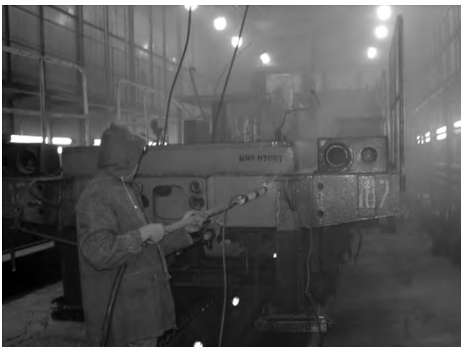
Рис. 1. Очистка поверхности металлоконструкций от застарелого лакокрасочного покрытия
